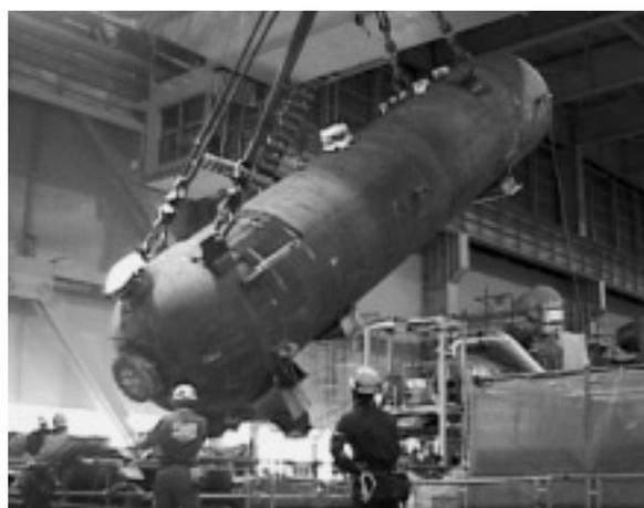
図1 開口部から斜め吊工法による熱交換器の搬出作業
