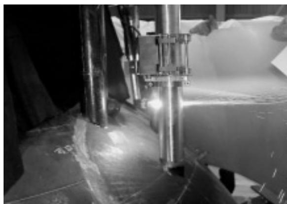
図2 モックアップによるCRDM管のプラズマ自動切断訓練
